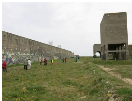
Les vestiges de l'ancienne usine de concassage de galets
