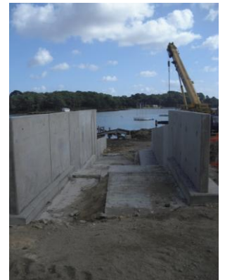
Ouvrage de stockage de bateaux
