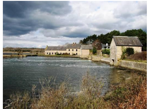
La digue du Roc'h Du
