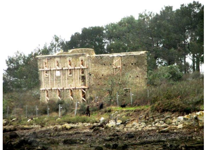
La ruine consolidée. 21 janvier 2018
